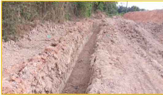
Canales de desfogue de aguas lluvias y cunetas existentes (internos).
